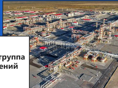
Газоперерабатывающий комплекс Кандым (LUOC)
